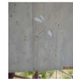
WEB CRACKING
